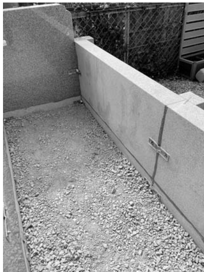
地震対策用『モノコック金具』の施工例。平らな面の継ぎ目部分には平型、入隅のコーナー部分にはL型と、取り付ける箇所に合わせて2種類の金具を使いわけている
