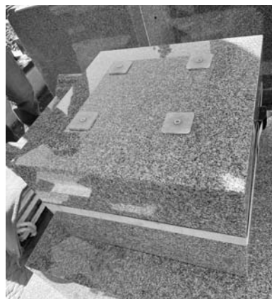
墓石用地震ゲル『泰震』と『タイシンボンドV』による免震施工のようす。お墓の地震対策は、墓参者の身の安全を守るために必要な責務となっている
