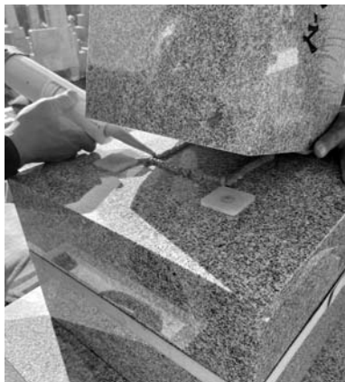
墓石用地震ゲル『泰震』と『タイシンボンドV』による免震施工のようす。お墓の地震対策は、墓参者の身の安全を守るために必要な責務となっている
